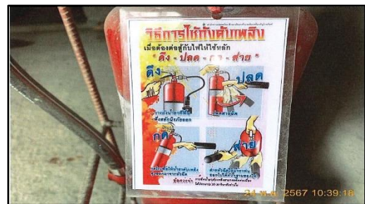
รูปที่ 48 วิธีการใช้ถังดับเพลิง
