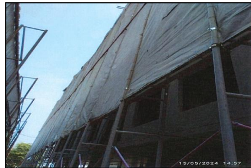
รูปที่ 13 ติดตั้งผ้าใบก่อสร้าง Mesh Sheet (ชนิดกันไฟลาม)
