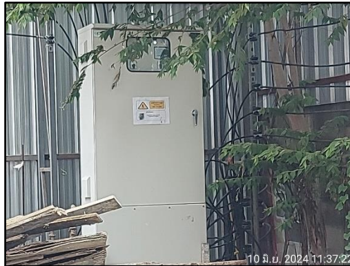
รูปที่ 41 หม้อแปลงและมิเตอร์ไฟฟ้าชั่วคราว
