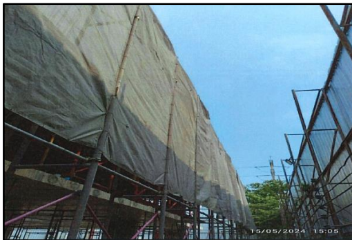
รูปที่ 13 ติดตั้งผ้าใบก่อสร้าง Mesh Sheet (ชนิดกันไฟลาม)
